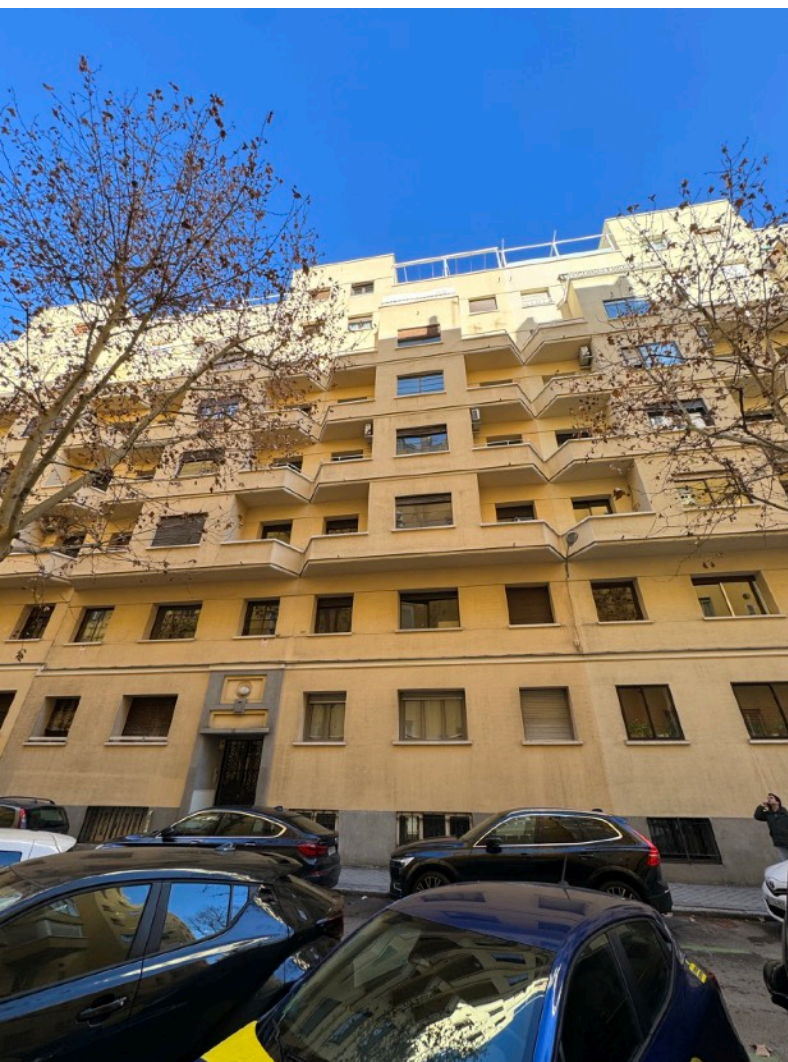
FACHADA DEL EDIFICIO
